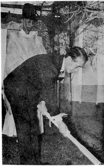
国文学研究資料館新営工事 地鎮祭(昭和47年10月12日)
