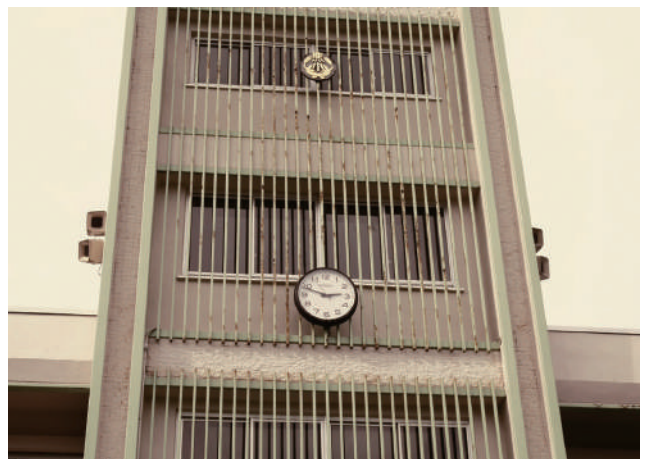
東日本大震災直後で時計が止まった大熊町立熊町小学校
