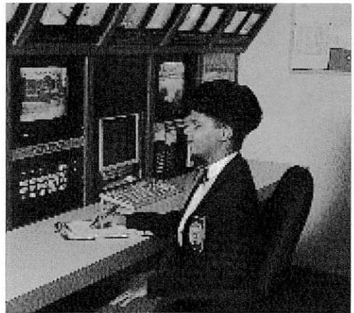
図26 24時間警備体制により建物と職員を守り、セキュリティー制御室に設置されたセキュリティー管理システムの監視を行う。写真のコンソールには、侵入警報とアクセス、CCTVモニター、ビデオテープレコーダー、及びメインインターホン端末が装備されている。
