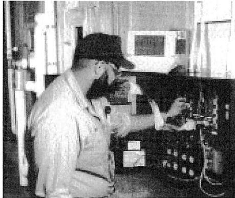
図7 空気処理制御ユニットでは、各収蔵庫内の気温、相対湿度、及びフィルターやダンパーの状態を監視することができる。
