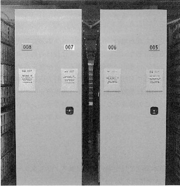
図18 台車の間に煙道を設けることで、消火にかかる時間を短縮し、移動書架システム内の収蔵物の火災による損傷を軽減。
