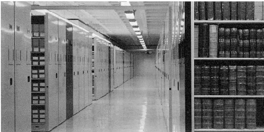
図14 資料を大量に収蔵した重たい台車や、特別長い台車の移動が求められることから、移動書架システムには電動式が採用された。すべての収蔵庫には、Spacesaver Corporation社とHarnischfeger Engineers, Inc社とのジョイントベンチャーであるH&S Constructors社が提供する移動式保管システムが設けられている。
