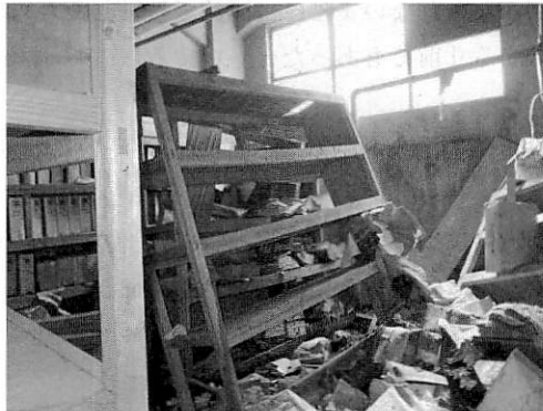
図画9 一部市庁舎1階に搬出して乾燥措置した文書のあった文書庫 (S課) の状況
