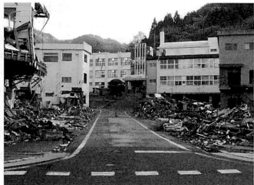
図画5 2012年5月8日釜石市役所第1庁舎
